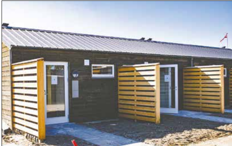
De skæve boliger er opbygget som træhuse med hør- og papirulds-isolering, og væggene er indvendigt beklædt med fermacell fibergipsplader, der bidrager til et sundt indeklima.
