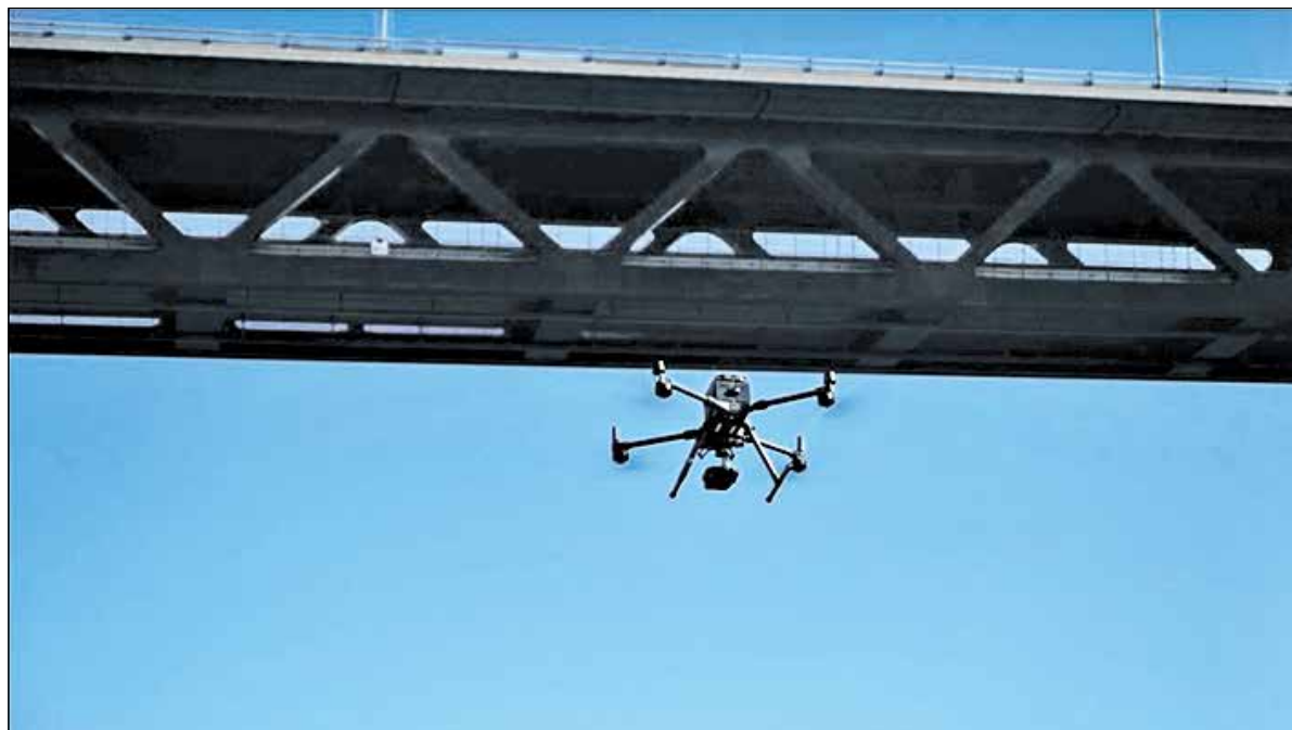
Dronen gør det muligt at fotografere de betonoverflader som tidligere krævede dristige alpenister.
