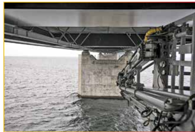
Inspektionsvognen hænger på skinner under Øresundsbroen.
