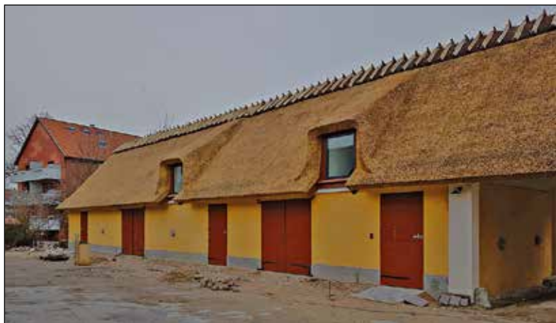
31. januar 2020 stod bygningen klar udvendig og De Frivillige Kustoder arbejdede energisk på at blive klar med nedpakningen, så de kunne flytte ind i de næsten færdige bygninger... men bygningen lod vente på sig. Senere... da bygningen var klar kom coronaen i vejen. Derfor venter vi alle sammen fortsat i spænding på at se det færdige resultat.
