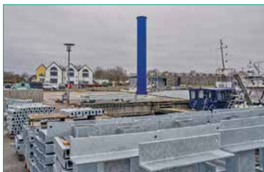
Længe stod den nye krans fundament og ventede på sin hat. Fundamentet er skruet fast på en fod, der er solidt banket ned i københavnerkalken, så den kan holde til løft på 20 ton.
