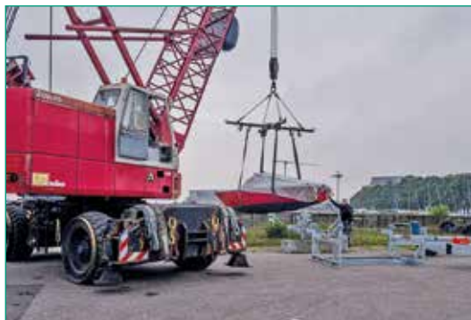
TIDLIGERE: Båden hejses op af vandet af den godt gennembrøvede mobilkran (foto) eller den kan sejle til den endnu eksisterende gamle kran.
