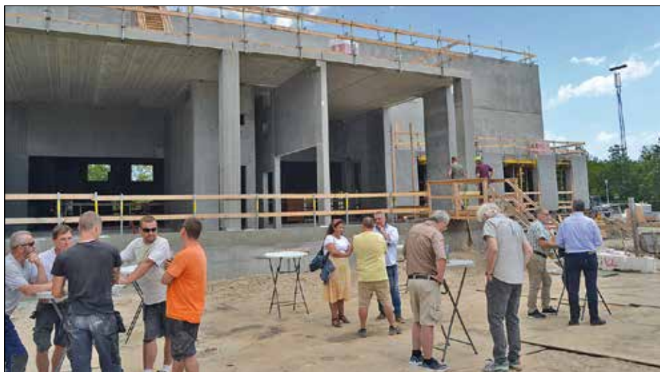
Et rejsegilde er håndværkernes fest med et traditionelt måltid af pølser og øl. Andre interesserede fik sig også et indblik bag betonvæggene, som fra efteråret 2020 rummer selve kernen i byggeriet - bassinerne. © Christian Askou, Tårnby Kommune.
