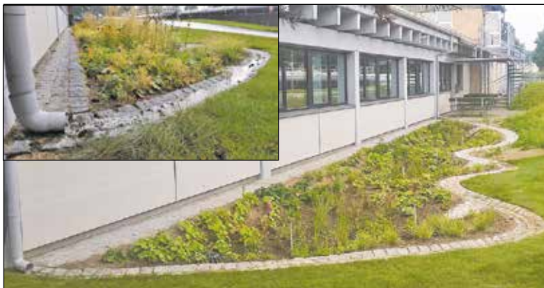
Fordampningsbedet, hvor der er en tæt membran i bunden, som sikrer, at regnvandet ikke siver ned og fører forureningen med ned til grundvandet. På det lille billede ses fordampningsbedet med rende af chausse-sten.
