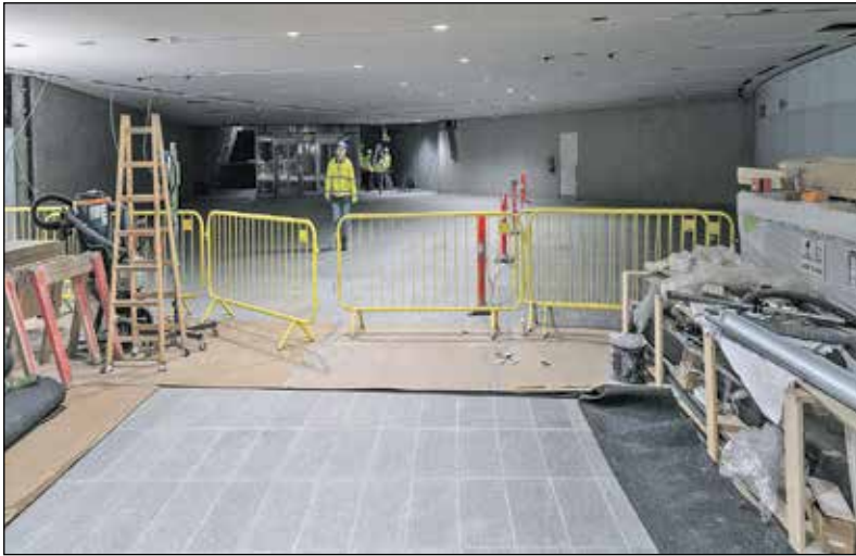
Foto 1. Et kig i tunnelen fra den gamle station mod den nye trappe. Passagerer til og fra Cityringen skal gennem en passage bag døren til højre. Man kan ane retningen ved at se på fugerne i gulvfliserne, der er af samme type som på den gamle station.
