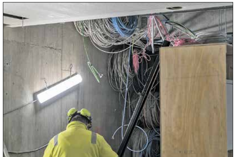
Hvad loftet gemmer: Der er meget, som pakkes ind og forbindes før passagererne lukkes ind i transittunnelen.
