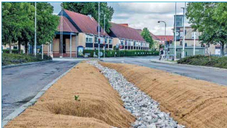
Overalt i samfundet bliver man mindet om vand fra oven og fra havets mulige ulyksaligheder. I Tårnby er der opmærksomhed på skybrud, som her en afvandingsgrøft fra Amager Strandvej ud mod lystbådehavnen. Mod vest er diget fra kysten til Tømmerupvej hævet til næsten seks meter. Foto: Kurt Pedersen, Amager Fotoklub.
