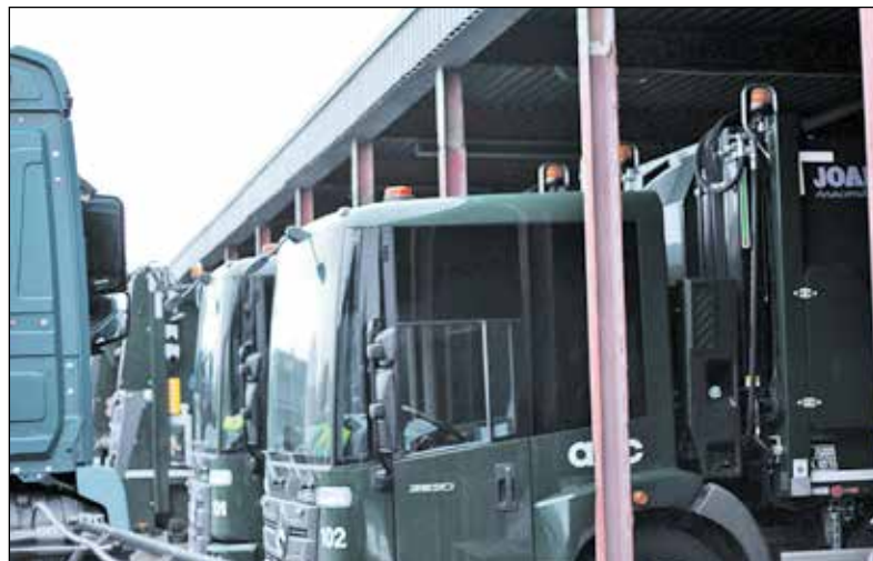
De nye skraldebiler, som må holde med snuden uden for garagen. Bemærk afskalling på de lodrette søjler, som viser, hvor langt nede portene var tænkt og opført.
