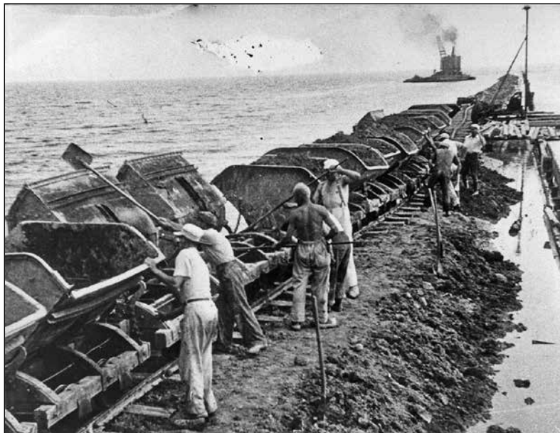
Digebyggeriet krævede et stort mandskab og masser af tipvogne efterhånden som diget 'stak til søs'. Her er man i begyndelsen af arbejdet. Senere blev vandet på indersiden af diget pumper ud i Køgebugt. Foto: Tårnby Stads- og Lokalarkiv, B 1399.
