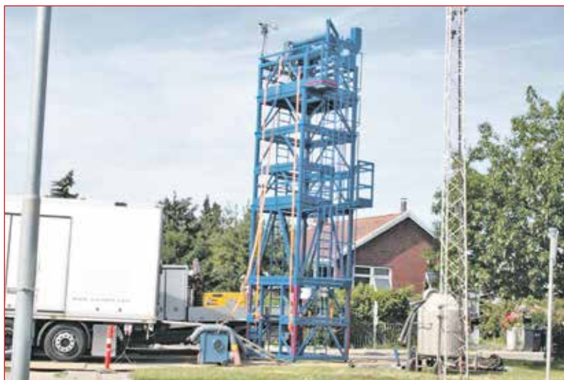
Det kræver højt vandtryk, når kloakkerne skal have indvendige sokker på. Aarsleff arbejder hver- og søndage med at fore kloakledningerne ved det gamle vandtårn og Englandsvej. Sokkeprincippet sparer mange opgravninger. Foto Ole Gjedved.
