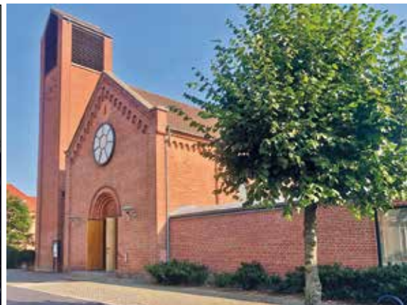
Den nye kirke, som vi ser den i Kastruplundgade i dag. Det er stort set kun fundament og ydermure, der er bevaret fra den tidligere kirke.
