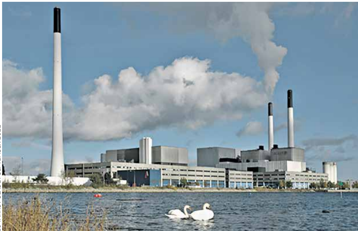
Palle Nissen var med til at bygge Amagerforbrændings høje skorsten (tv. i foto) – i døgndrift og i 12 timers vagtskifter. Støbearbejdet foregik med en glideforskalling, der hele tiden blev ført opad, mens støbningen stod på. Man må aldrig lade cementen hærde – så holder det ikke sammen mere, trods jernforstærkningen. Foto: ARC
