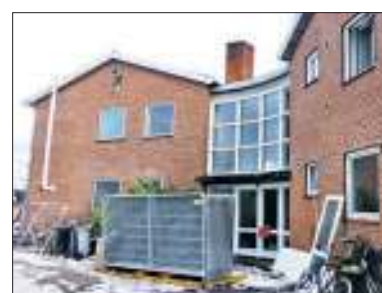
Som Glamsbjergvej 22 så ud i sine sidste timer før nedrivningen. Her skal være eksklusive lejligheder i det tidligere industri-område, som Amager Auto Service har været en del af i mange år.
