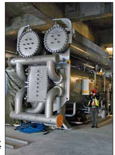
En af de nye miljøvenlige filtre, der er indbygget i det nye forbrændingsanlæg.
