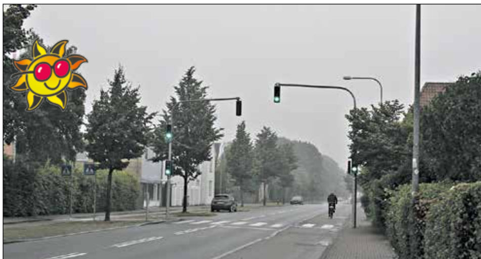
LYS OVER SALTVÆRKSVEJ: Så lykkedes det at få taget et foto af et færdigt lysanlæg på Saltværksvej endda med lys i. Fodgængerovergang og lysanlægget erstatter en overgang, der har været nedlagt i mere end et halvt år og som var vigtig, da mange skolebørn krydser vejen, når de skal fra blandt andet Skottegården til sportsanlæggene eller Kastrupgårdsskolen på Sirgræsvej. Lyset kan skifte til rødt på "opfordring". Håbet er, at fodgængere har tålmodighed til at vente på sikker overgang. Foto: Ole Gjedved.
