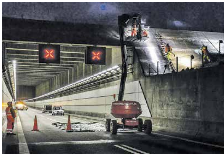
Her blev der udskiftet forskelligt teknisk udstyr, blandt andet et påkørt lysskilt, sat ny belysning op ved nøddørene, og repareret beton ved tunnelmundingen.
