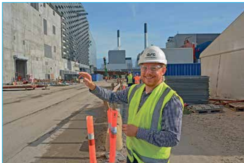
Kommunikationschef Morten Kramer Nielsen viser stolt byggeriet frem. Her set fra nordsiden, hvor pisten kommer til at ende.
