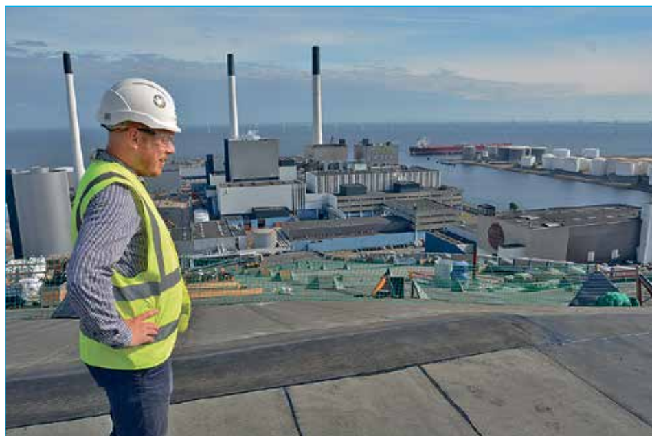
Udsigten fra toppen af Amager Bakke er storslået, men skrækindjagende. Men der kommer sikre rækværk på inden skiløbere slippe løs på den "sorte løjpe".
