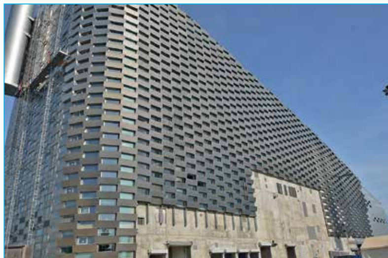
Facaderne på Amager Bakke er beklædt med rektangulære metalpaneler afbrudt af vinduer i samme størrelse. Det giver en flot relieffeffekt.
