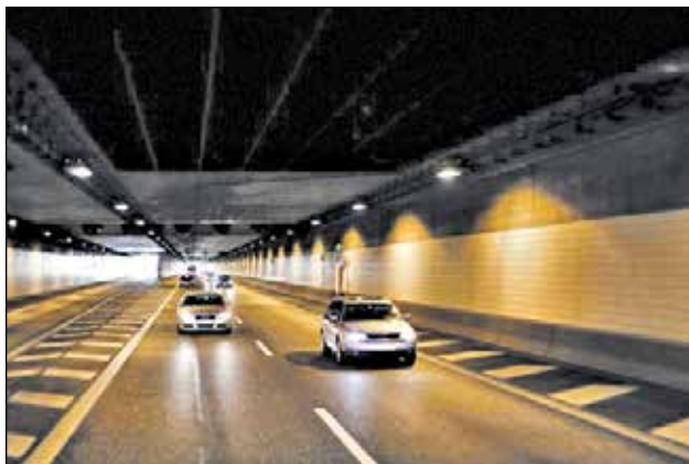
Både motorvej og jernbane løber i en tunnel i Tårnby ved Vinkelhuse for at genere beboere og miljø mindst muligt. Oven på tunnelen er der anlagt grønne områder.
