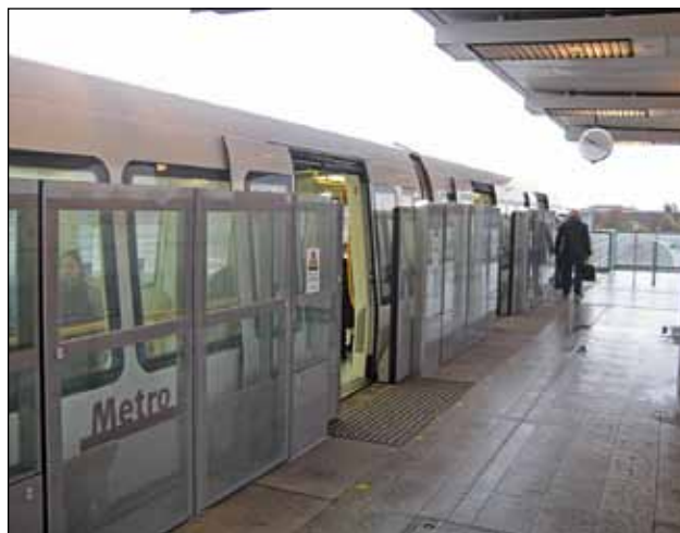
Derimod er perrondørene, som skal sikre bedre regularitet og færre unødvendige nødstop, færdige og taget i brug på Femøren og Kastrup Station.
