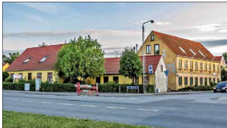
Når fejlen kunne opstå skyldes det, at en hel række af de gule bygninger som lå bag Düvers Maskinfabrik er blevet jævnet med jorden og mange fejlagtigt troede, de sidste bygninger også stod for fald. Men man bør ikke tro – man skal vide! Foto: Kurt Pedersen.
