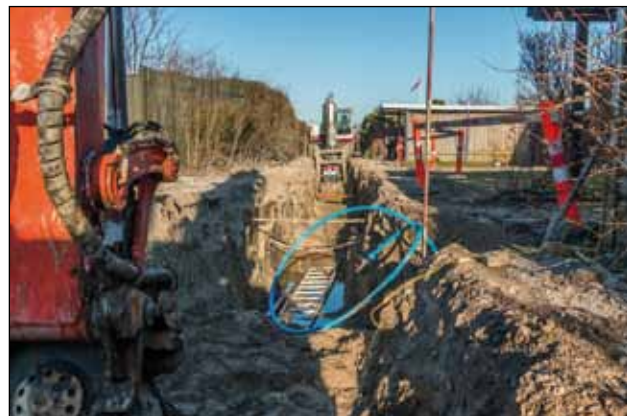
Haveforeningen Selandia på Viberupstræde er af egen fri vilje gået i gang med at kloakere de 221 parceller. Det koster godt 85.000 kroner for hver, men det har man valgt for miljøet skyld.
