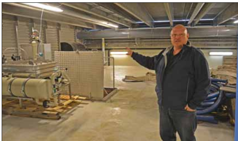
Morten Rasmussen demonstrerer her et mobilt renseanlæg, som kan filtrere overfladevand, så det bliver så rent, at det kan bruges til drikkevand. Det kan vise sig meget anvendeligt i områder som for eksempel Afrika og andre steder, hvor man ikke har tilstrækkeligt med drikkevandsressourcer.
