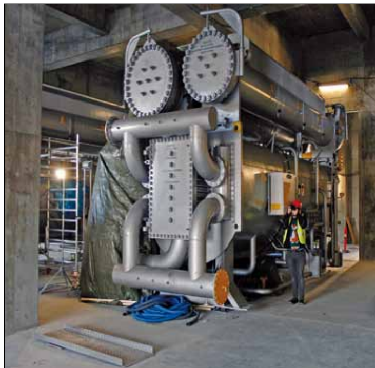
Det er ikke kun bygningerne, der er gigantiske. Maskineriet er det også og må løftes ind i konstruktionen, mens den er under opførelse. Til venstre er det filtrer til forbrændingsanlægget og til højre en varmeveksler.
