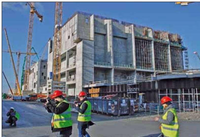
Det er noget af en kolos, der er ved at tage form på Østamager. Og man er endda kun halvvejs med byggeriet.
