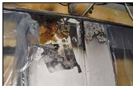
Varme fik glassene i vinduerne og i udstillingsmontrene til at sprænge og sod fra smeltede vindueskarme og lofter bredte sig i hele udstillingen. Se herunder.
