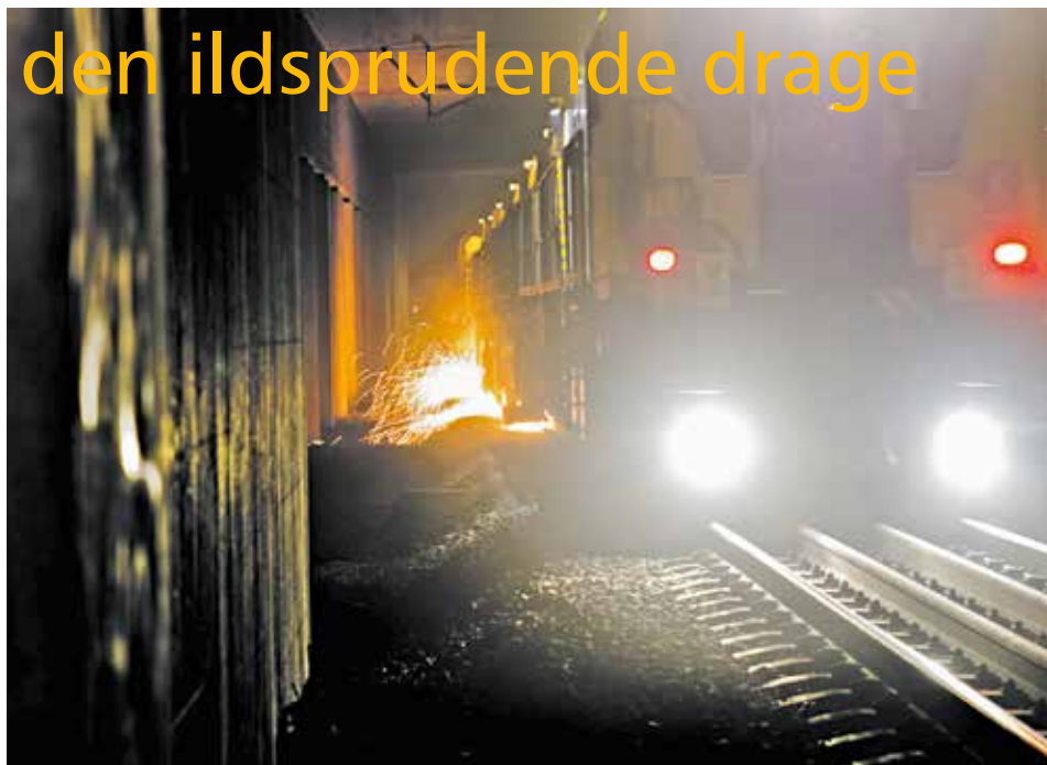
Skinneslibetoget gnister og støjer, når det kører hen over skinnerne. Det ser nærmest ud, som om der er gået ild i skinnerne under toget. Derfor arbejder det også kun om natten, for ikke at genere naboer og også for at genere togdriften mindst muligt.
